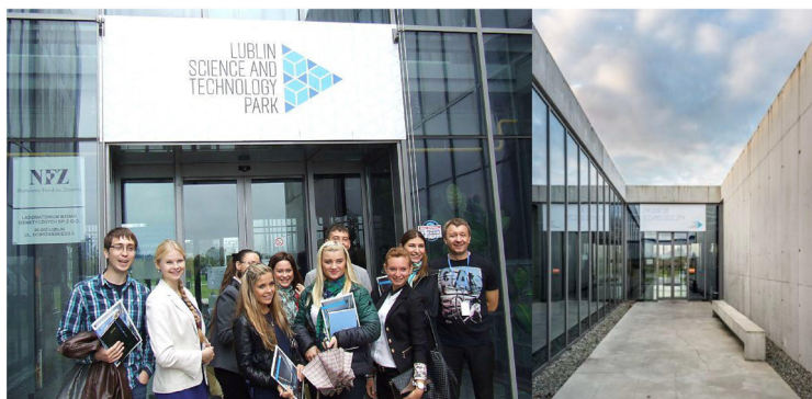
Rys. 4.1. Zastosowanie szkła w budynku Lubelskiego Parku Naukowo-Technologicznego [27].
