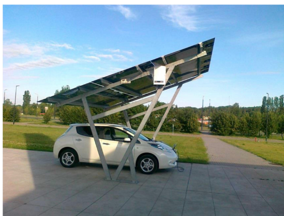
Rys. 2.28. Podłączenie pojazdu do carportu fotowoltaicznego
