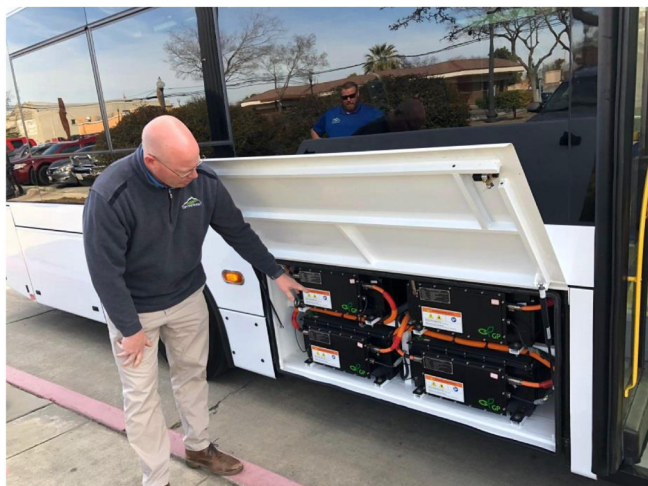
Rys. 2.20. Miejsce montażu pakietu baterii w luku bagażowym autobusu [115]
