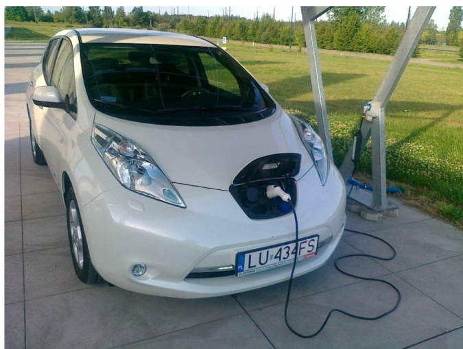
Rys. 2.30. Podłączenie pojazdu do carportu fotowoltaicznego
