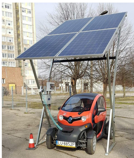
Rys. 4.14. Pojazd elektryczny podczas ładowania baterii z minicarportu fotowoltaicznego
